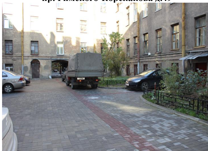
Дворовая территория после выполнения работ по благоустройству пр. Римского-Корсакова д.49
