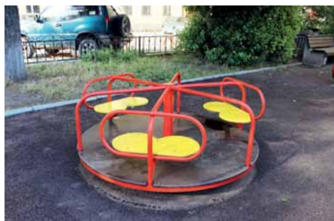
Английский проспект, д.17—19: демонтаж сломанной карусели, установка новой карусели «Звездочка».
